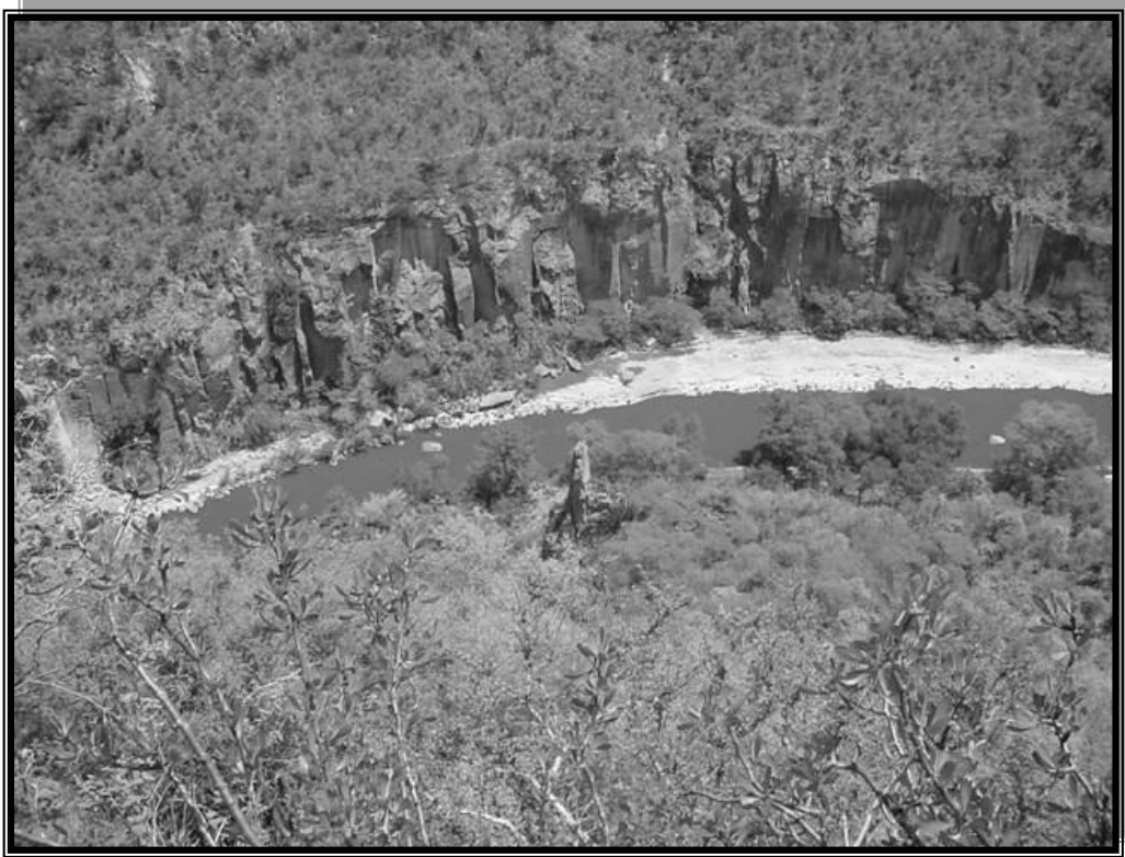
Foto N° 3 Vista aérea del cauce del Río Verde y de la vegetación, cerca de donde se construirá la cortina
